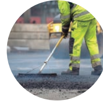
CARRETERAS Y ASFALTO
