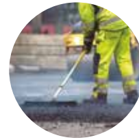
CARRETERAS Y ASFALTO
